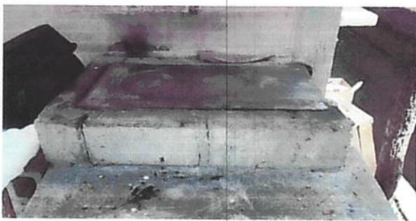
Foto 5: Sustitución de polleton por estufa rural completa incluye chimenea y plancha de metal
