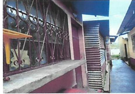
Foto 2: Sustitución de pared de cocina de lámina por block
